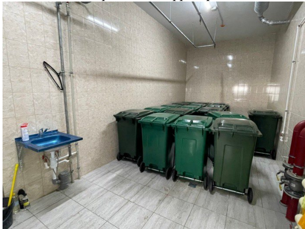
Помещение для временного хранения мусора
