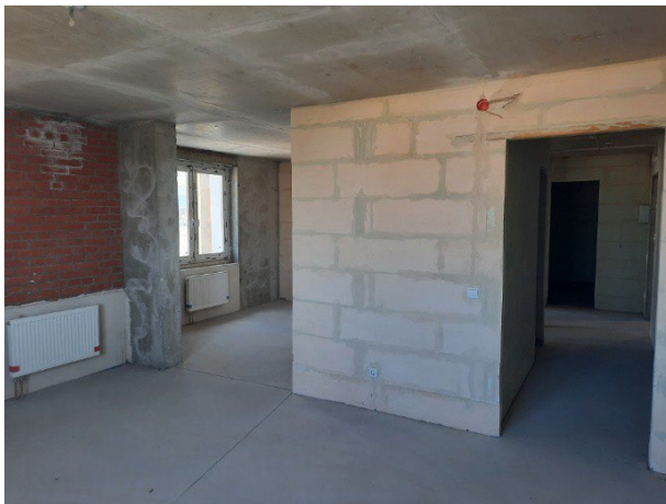
Черновая отделка в квартире
