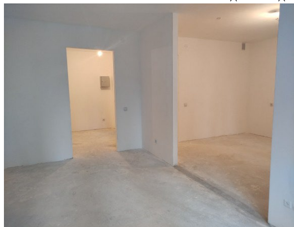
Отделка под чистовую в квартирах
