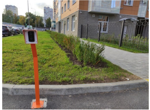
Система контроля и управления доступом
