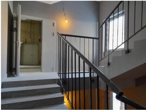
Лестница на 2 этаж
