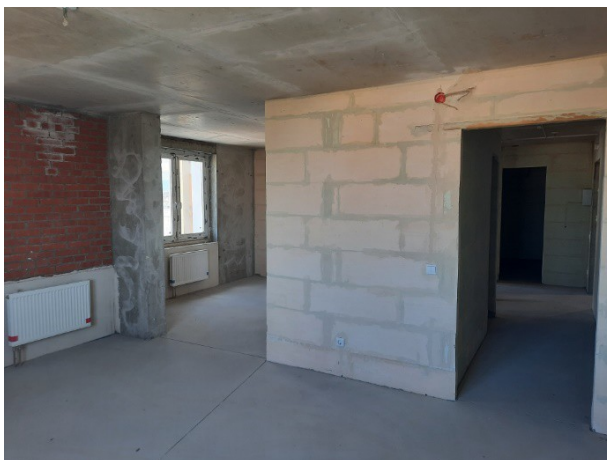
Черновая отделка в квартире
