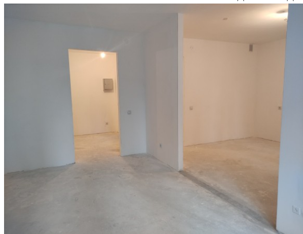
Отделка под чистовую в квартирах
