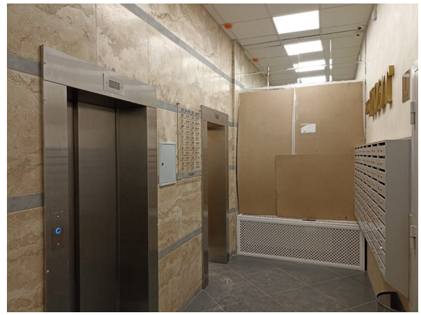
Лифтовой холл на 1 этаже
