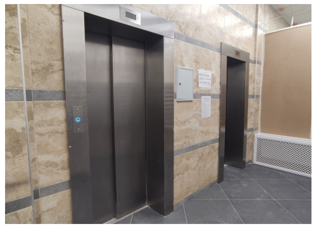
Лифтовой холл на 1 этаже
