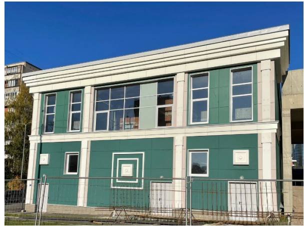
Вид с южной стороны
